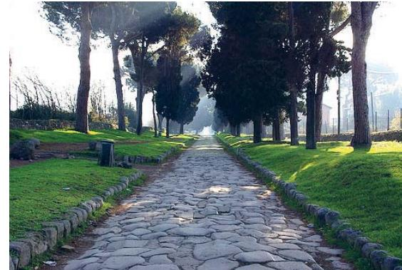
**Slika 2.** Primjer rimske ceste ogradijene rubnim kamenom i s bočnom odvodnjom oborinske vode
