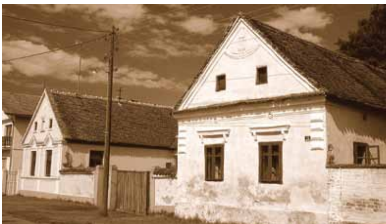
Dvije zidanice - jedinke iz Kalinovca, zidane 20-ih godina 20. stoljeća (foto: Ž. Car, 2008.)
