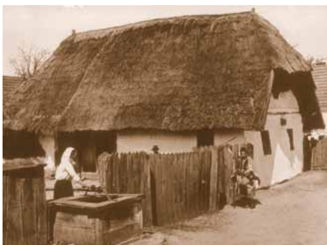
Fotografija starinske kuće sa skraćenim trijemom - primjer iz Novigrada Podravskog, Ulica Trnovec, srušeno (foto-arhiva D. Feletara, 1973.)
