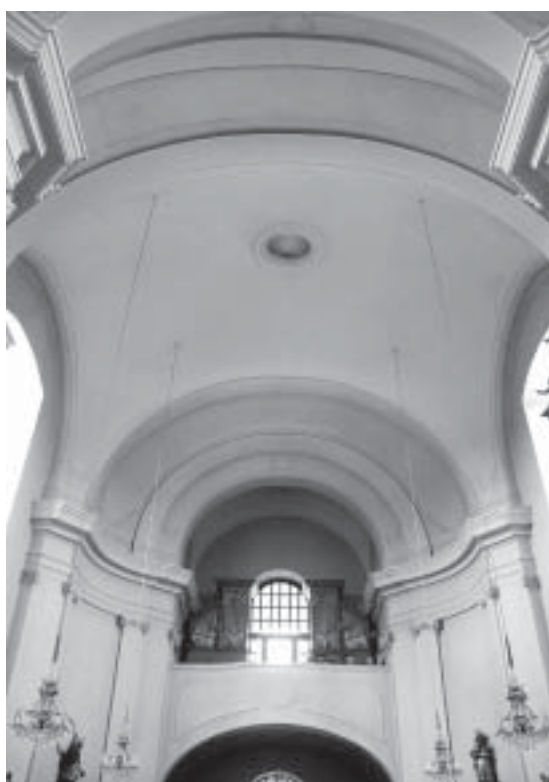
Slika 17: Ollersdorf, župna crkva sv. Leonharda, pogled prema pjevalištu (foto: Jovan Kliska)
