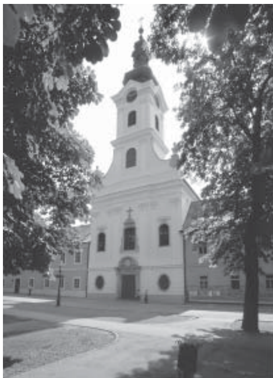
Slika 9: Bjelovar, prvotno pijaristička i župna crkva sv. Terezije, pročelje (foto: Milan Drmić)
